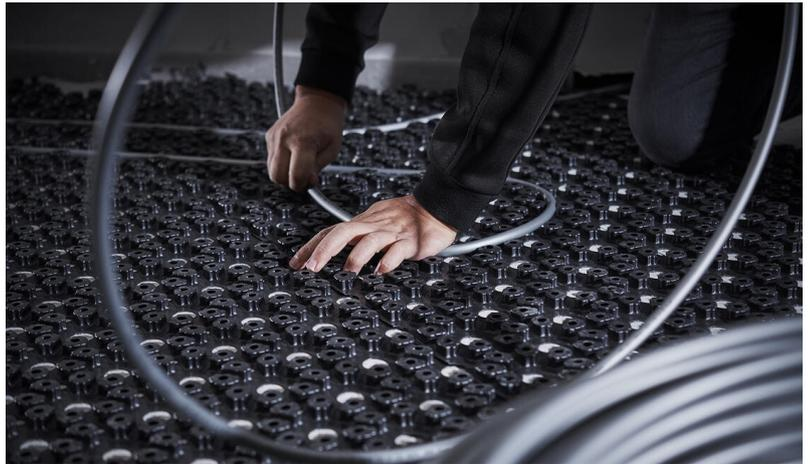
**Beim nassen Dünnschicht-Verbundsystem wird die Folie auf den Boden geklebt. Anschliessend lassen sich die Heizrohre nach Schema einklicken.**
